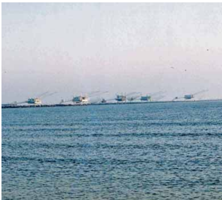
Marina di Ravenna, diga foranea di levante.
